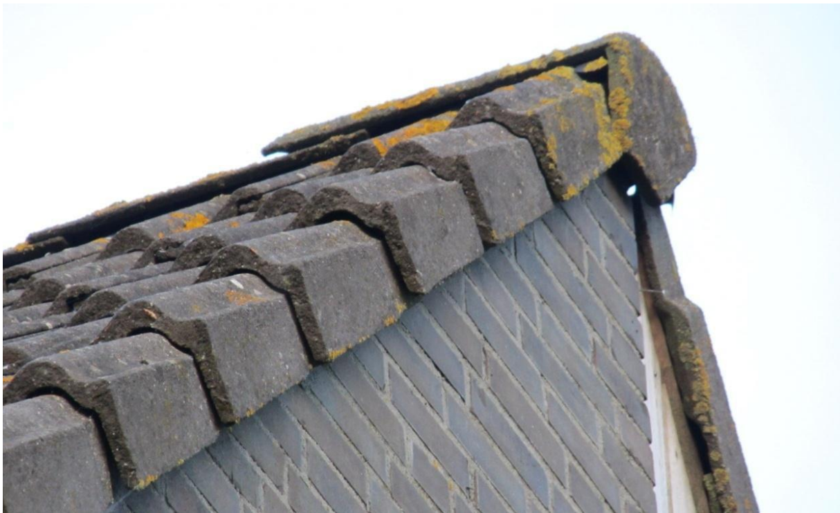
Figuur 1. RBB-dakpannen (1985) van een woning met een kolonie van twintig laatvliegers. Noordlaren, april 2014 (Klarissa Nienhuys). Double-S roof tile roof with a colony of twenty Serotines
